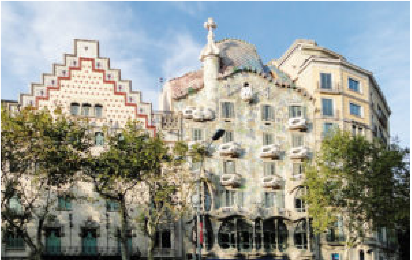
Passeig de Gràcia: Casa Amatller and Casa Batlló
